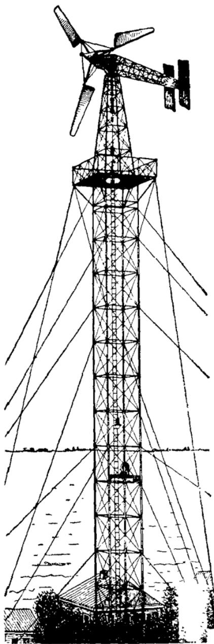
Рис. 153. Ветродвигатель системы Уфимцева — Ветчинкина Д-10.
