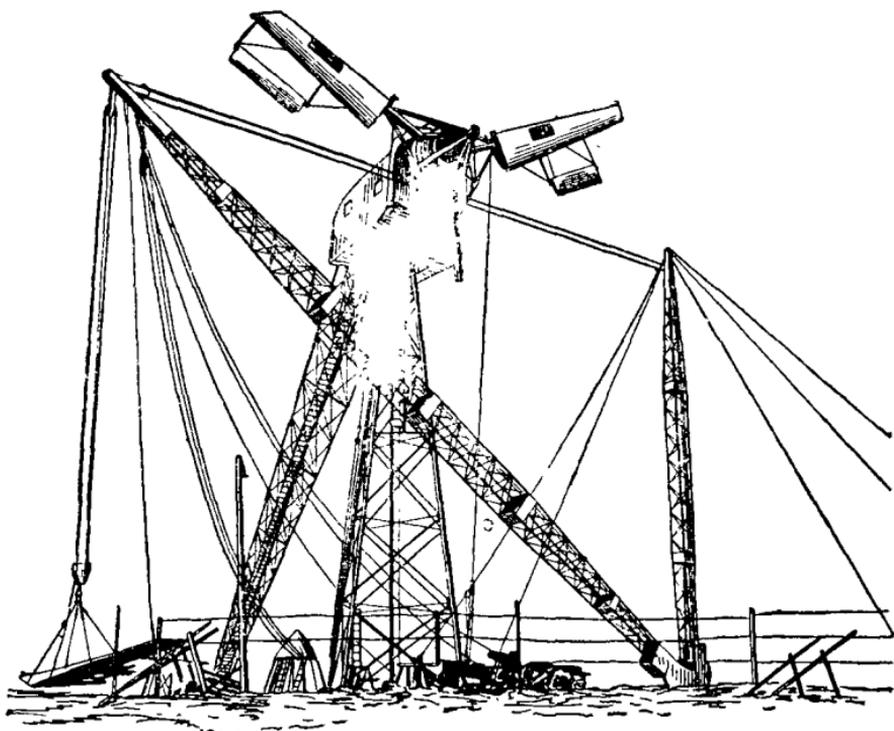
Рис. 342. Монтаж ветродвигателя с помощью крана «Дерик».
