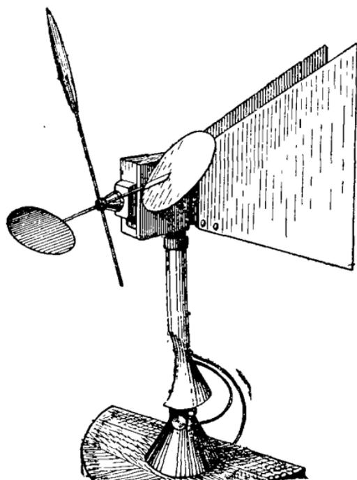
**Измерительная аппаратура** экспериментальной башни подобрана с таким расчётом, чтобы получить полную аэродинамическую характеристику ветряка. При испытаниях требуется измерять: мгновенные и средние скорости ветра, крутящие моменты и число оборотов ветряка.
