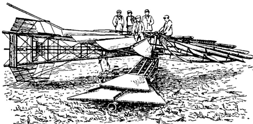
Рис. 338. Проверка оснстки ветродвигателя.
