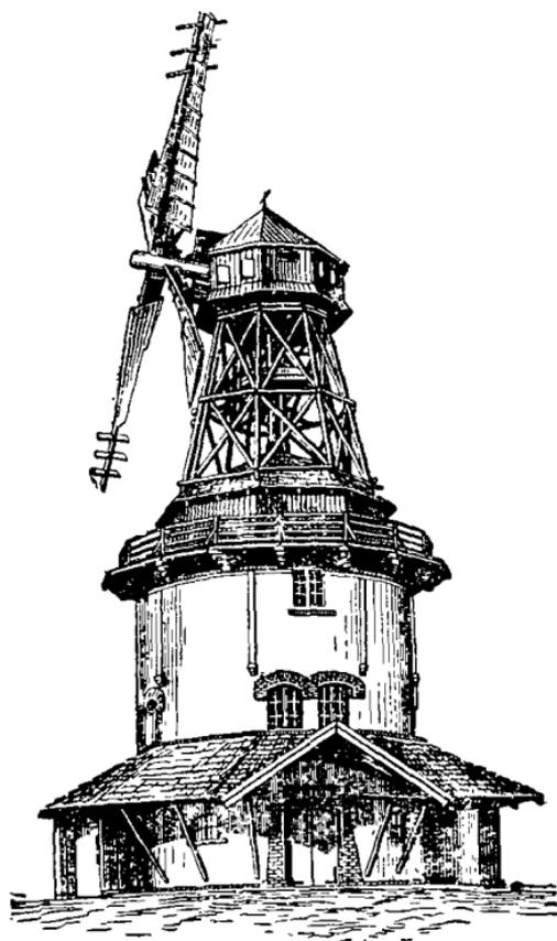
Рис. 296. Ветряная мельница Промзнеропроекта усовершенствованного типа с ветродвигателем ВЦМЭ Д-16.
