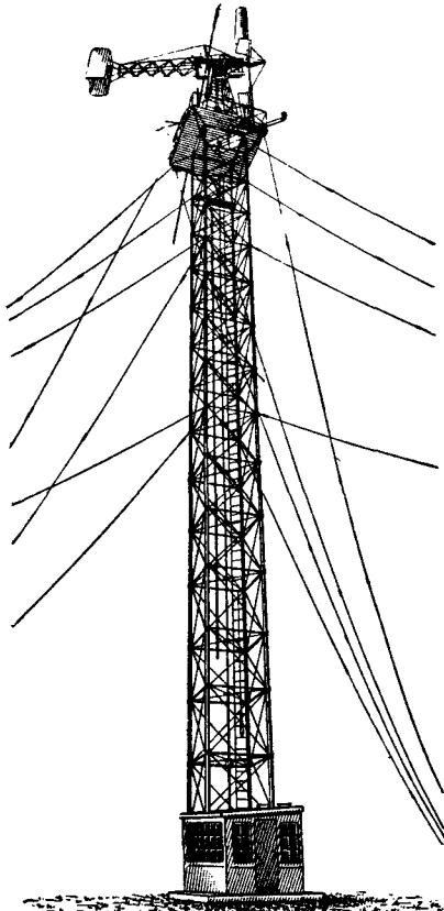
Рис. 76. ВЭС А. Г. Уфимцева с инерционным аккумулятором в г. Курске.
