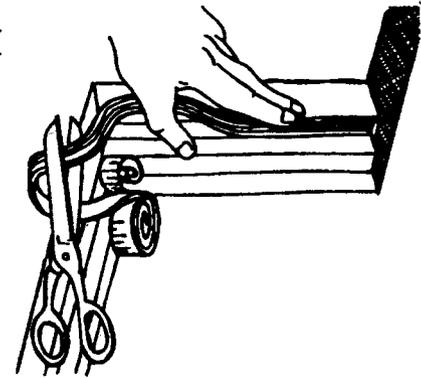
Для уплотнения окон можно воспользоваться пенопластом, оставшимся от упаковки аппаратуры или техники. Являясь хорошим теплоизоляционным материалом, он легко уплотняется, не пропускает холодный воздух через щели, защищает от дополнительных теплопотерь и долго сохраняет белый цвет. Кусок пенопласта режут острым ножом или паяльником на полосы, шириной чуть больше ширины щели и укладывают прокладки в щель так, чтобы пенопласт входил в нее с "натягом".
