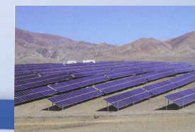
Кони-Алтайская солнечная электростанция. Введена в эксплуатацию в 2014 г.
