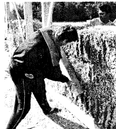
Укладка соломенных блоков в каркасную стену.
