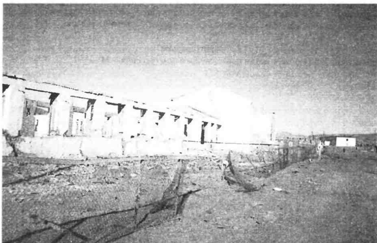
Рис. 1. Разрушенная землетрясением школа
