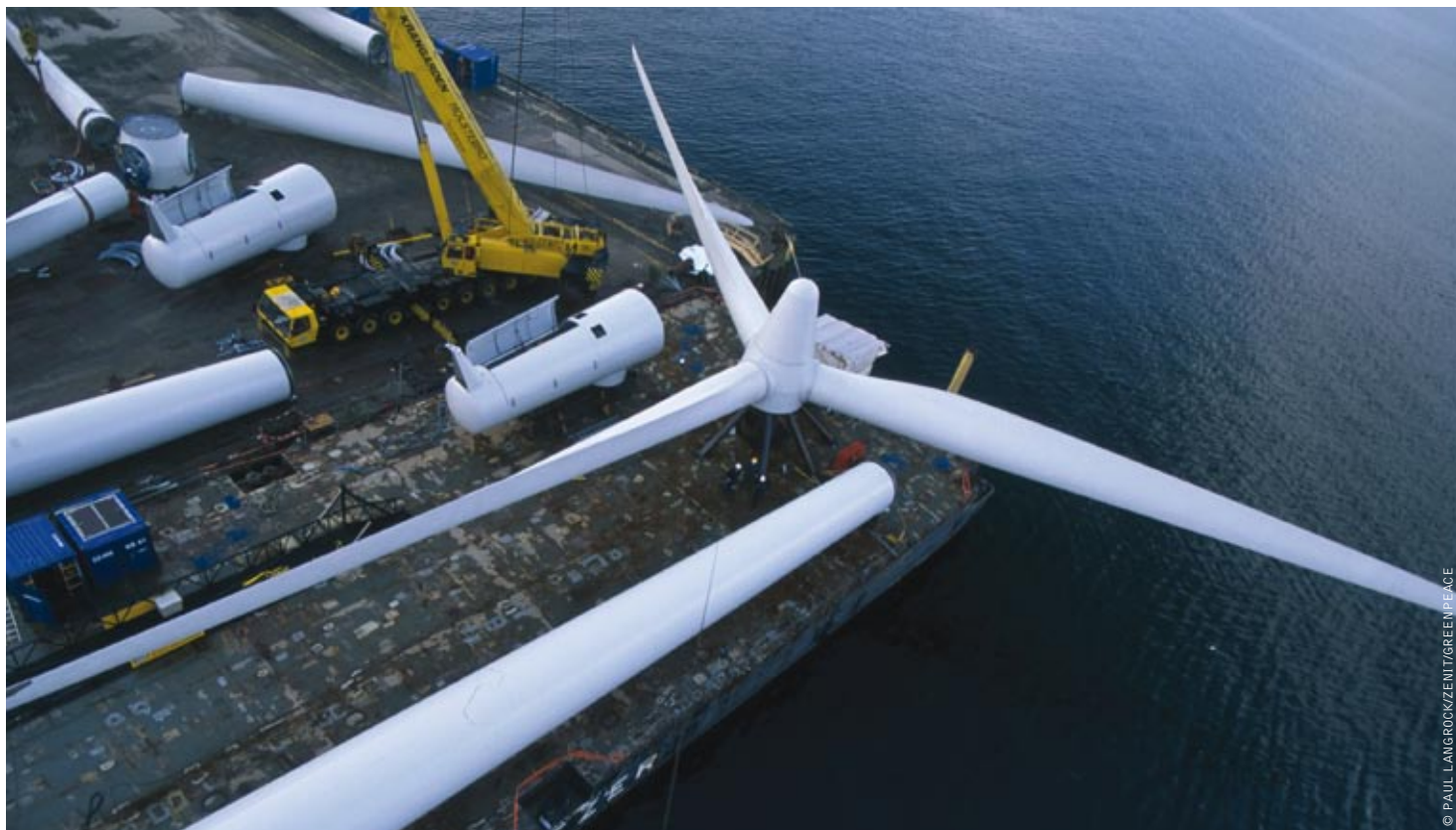
На снимке: строительство ветропарка в Мидделгрюндене. Окрестности Копенгагена, Дания.
