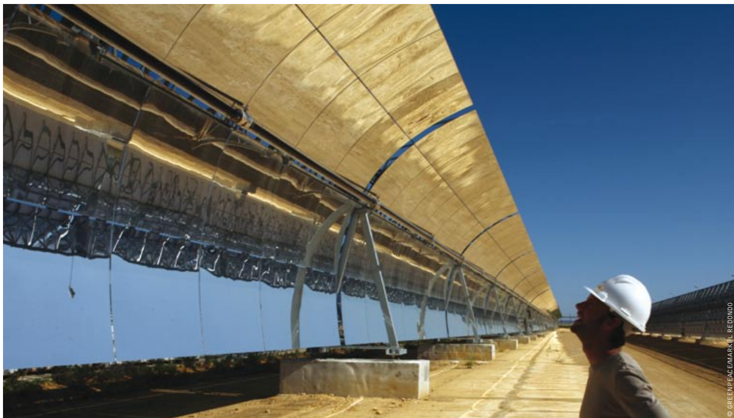
На снимке: ПАРАБОЛОЦИЛИНДРИЧЕСКИЕ КОНЦЕНТРАТОРЫ НА СОЛНЕЧНОЙ ТЭС PS10 В СЕВИЛЬЕ (ИСПАНИЯ). КАЖДЫЙ ПАРАБОЛОЦИЛИНДРИЧЕСКИЙ КОНЦЕНТРАТОР ПРОТЯЖЕННОСТЬЮ 150 М НАПРАВЛЯЕТ СОЛНЕЧНУЮ ЭНЕРГИЮ НА СПЕЦИАЛЬНЫЕ ТРУБЫ С ТЕПЛОСИТЕЛЕМ. НАГРЕТЫЙ ТЕПЛОСИТЕЛЬ ЧЕРЕЗ ТЕПЛООБМЕННИК ПЕРЕДАЕТ ЭНЕРГИЮ ПАРУ, КОТОРЫЙ ПОДАЕТСЯ НА ТУРБОГЕНЕРАТОР.
